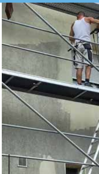
meglévő homlokzati felület előkészítése szigetelésre
