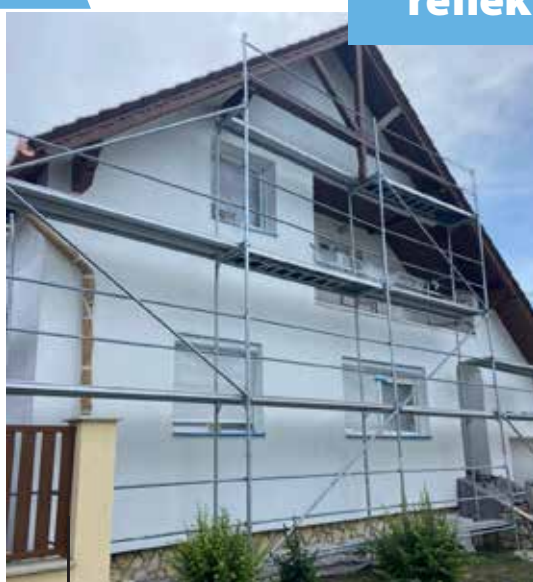
alapozás és első réteg
